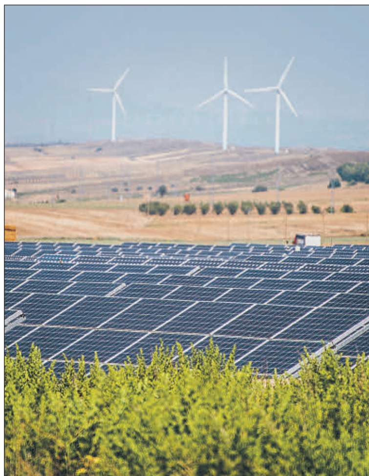
Una central fotovoltaica. ISTOCK
